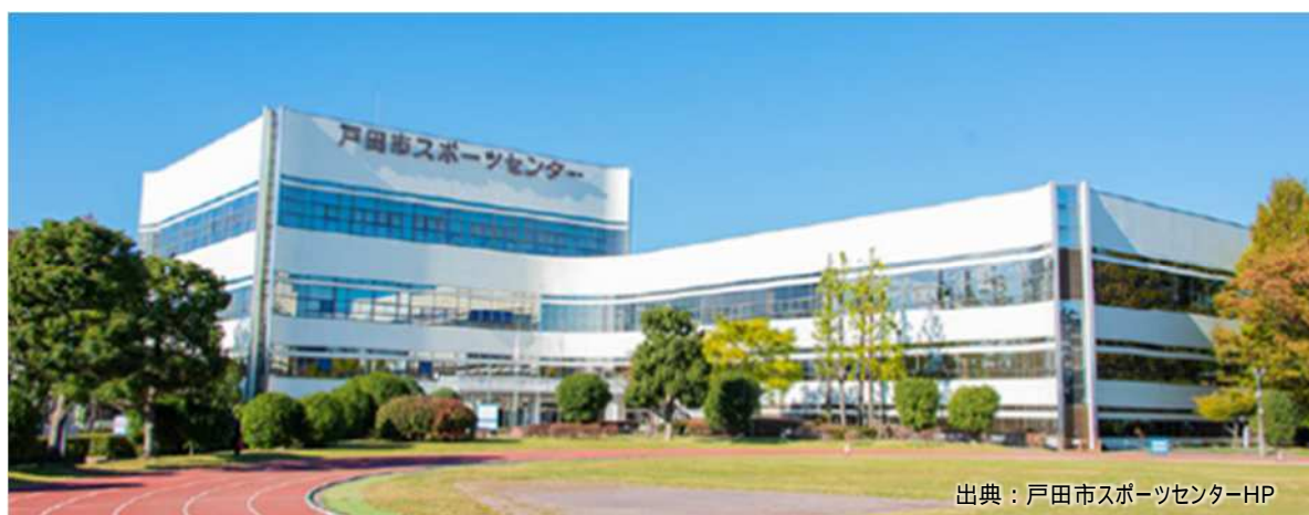
図 2 - 2 スポーツセンターゲーム棟・センター棟
