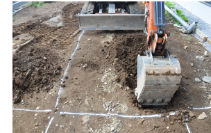
試掘調査 (重機掘削)
