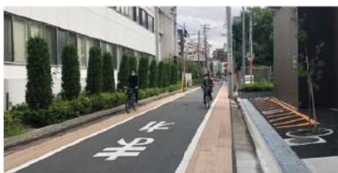
道路空間整備の一例 (路側帯のカラー舗装)
