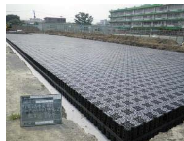
浸透施設の設置工事
