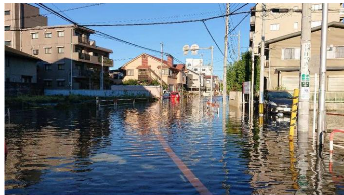
図1-2 令和元年（2019年）台風第19号により冠水した道路
