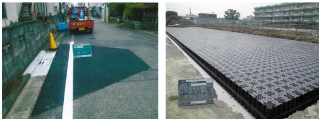
図3-19 (左) 道路の浸透樹の設置、(右) 浸透施設の設置工事
