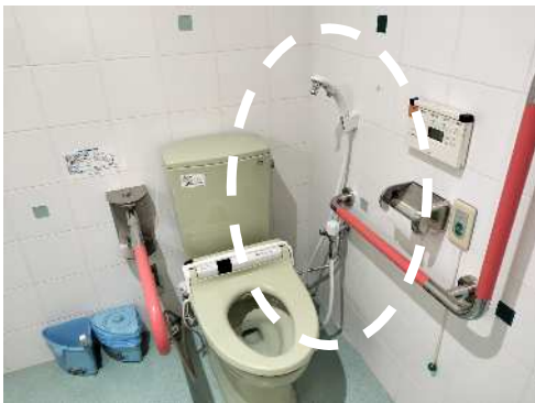
バリアフリースイレ施工例（戸田第二小）
