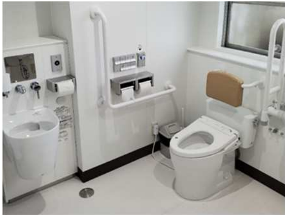
バリアフリースイレ施工例（戸田中）
