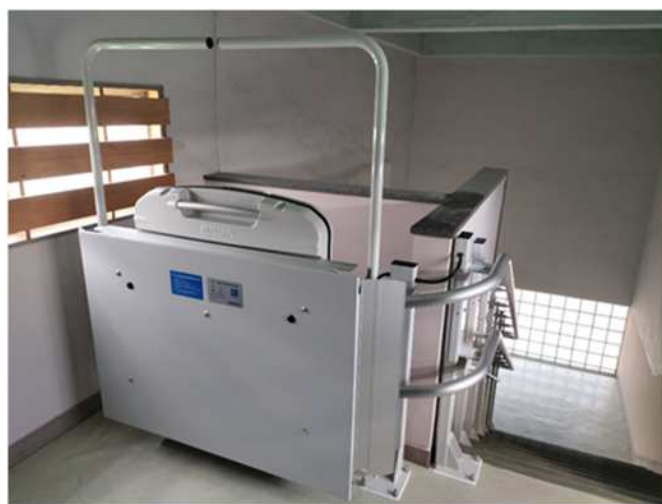
段差昇降機の設置状況（戸田南小）
