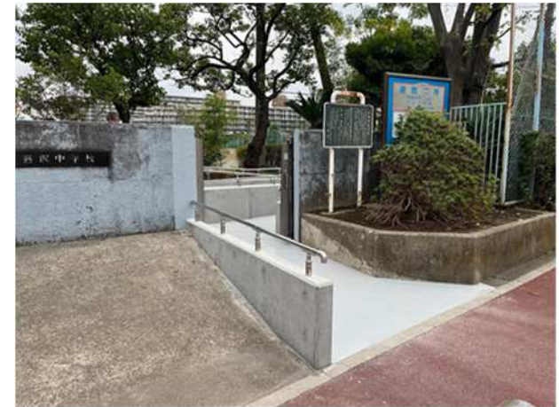
敷地出入口のスロープ
