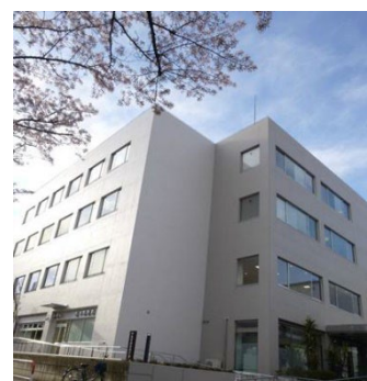
新曽南庁舎・新曽南多世代交流館
