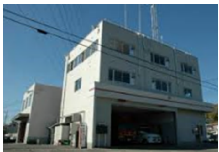
(西部分署庁舎)
