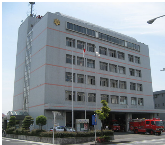
(消防本部庁舎)
