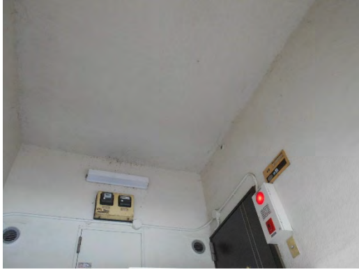
⑤ 壁・天井概ね良好（階段室）
