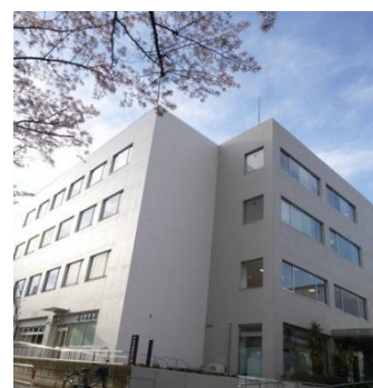
新曽南庁舎・新曽南多世代交流館
