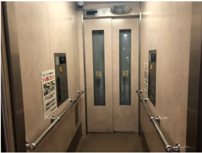
◎スルー式のエレベーターは車いす使用者等が転回する必要がなく利用しやすい
