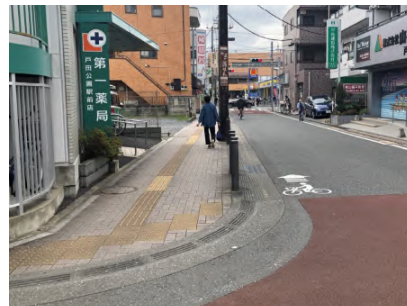
◎セミフラット構造の歩道で、歩車道境界にも段差がなく、平坦で歩きやすい
