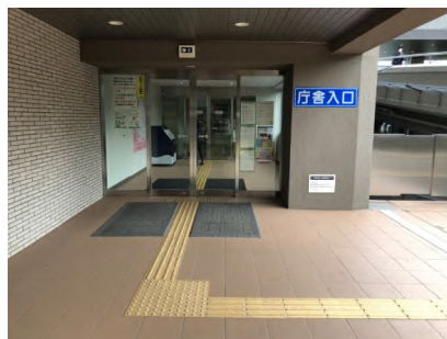
◎出入口への誘導用ブロックの設置や音声案内、自動ドアにより利用しやすい
