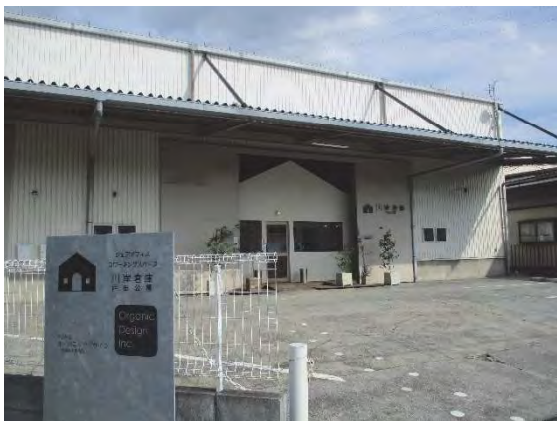
リノベーションされた川岸倉庫
