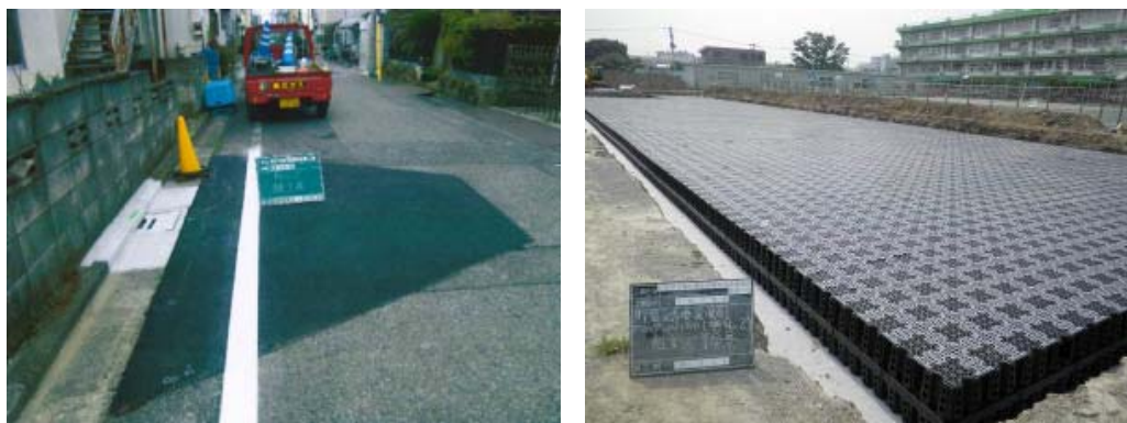
図3-19 (左) 道路の浸透柵の設置、(右) 浸透施設の設置工事
