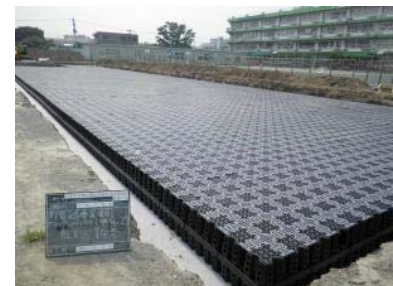
浸透施設の設置工事
