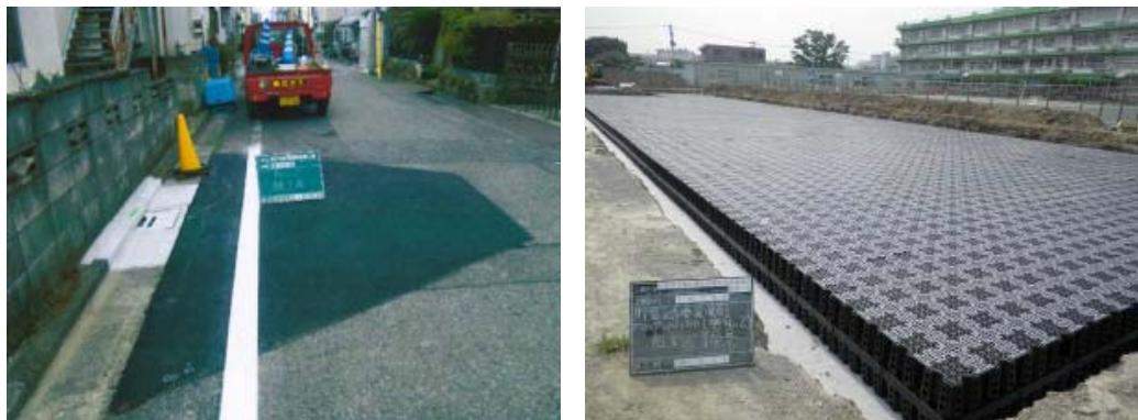
図3-19 (左) 道路の浸透枠の設置、(右) 浸透施設の設置工事
