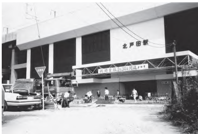
埼京線北戸田駅 昭和60年(1985)
