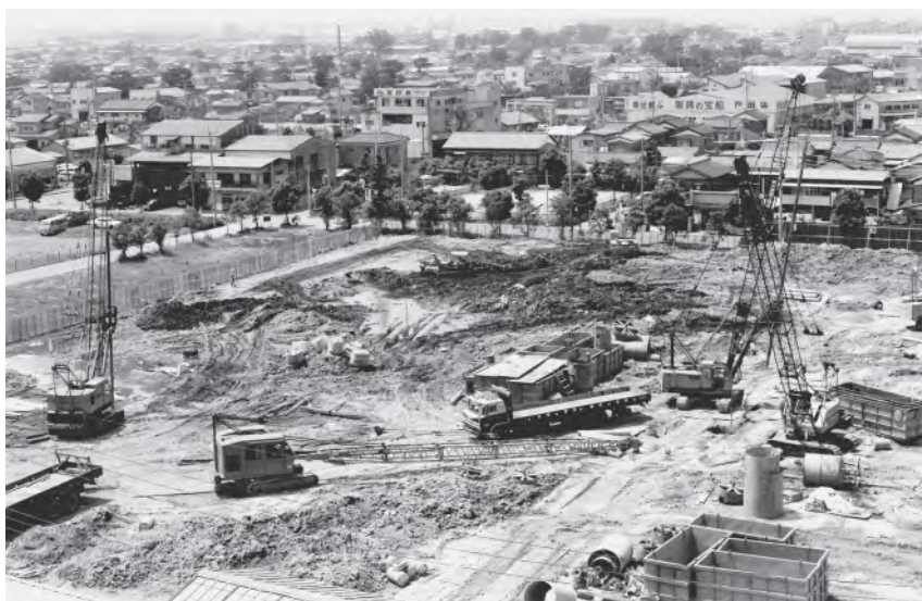
文化会館建設 昭和54年(1979)
