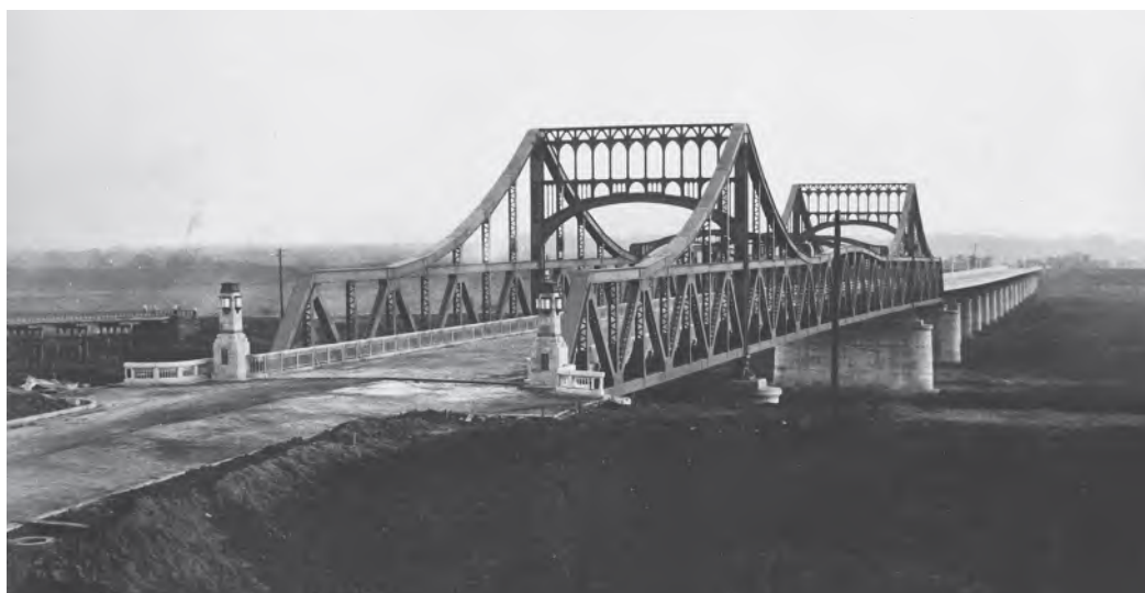
鉄橋戸田橋（3代目） しょうわ 昭和7年(1932)
