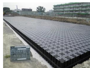
浸透施設の設置工事
