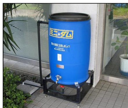
図 2-10 雨水タンク設置例
