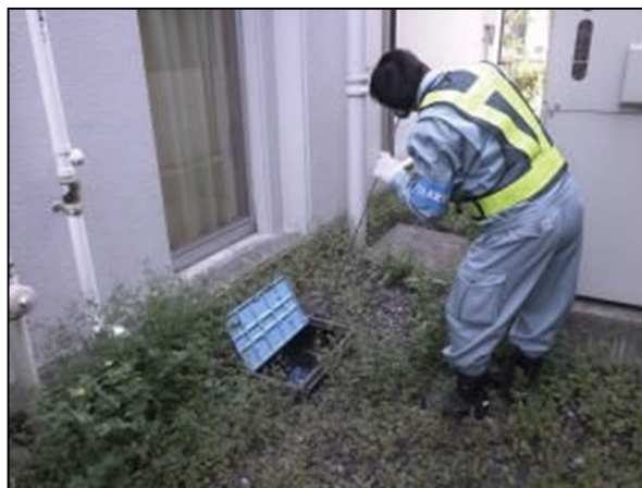
図 2-4 漏水調査の様子(戸別音聴調査)
