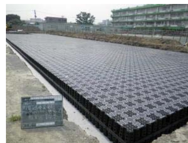
浸透施設の設置工事
