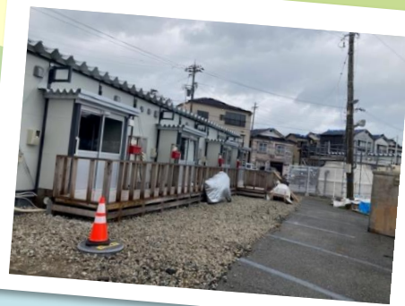
輪島港付近の仮設住宅
