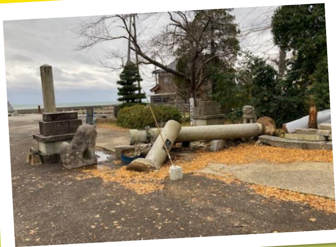
倒壊した須須神社(珠洲市)の鳥居
