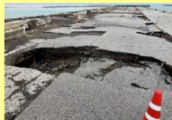
地盤沈下で崩壊した飯田港の埠頭
