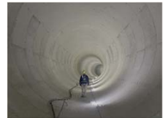
雨水貯留管の内部
