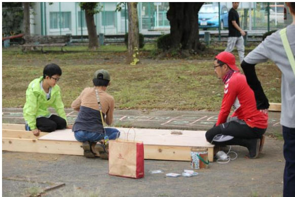
▲子どもたち主体で進む、滑り台の設置
