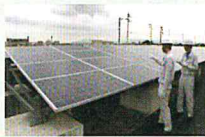
太陽光発電設備の検査の様子
