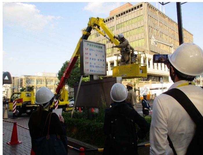
看板点検（文化会館）
