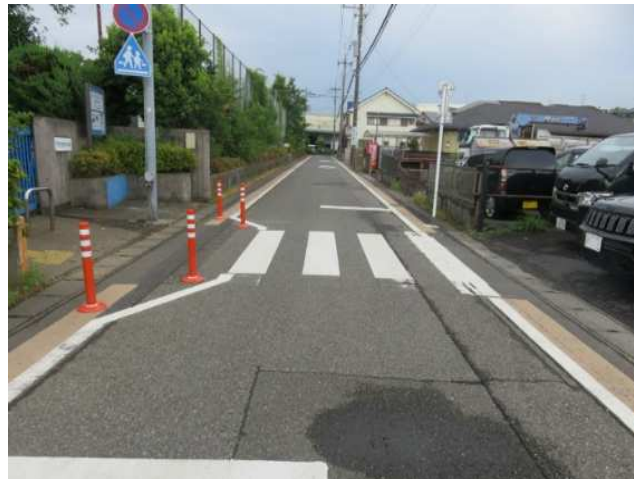
図4 - 18 施工例(狭さく)
