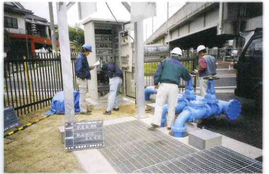
取水施設の運転確認
