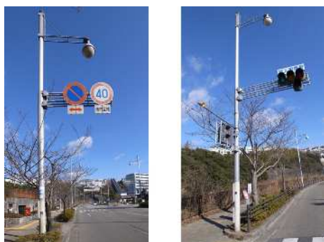
信号、道路標識、道路照明などが煩雑にならないよう一体化しています。
