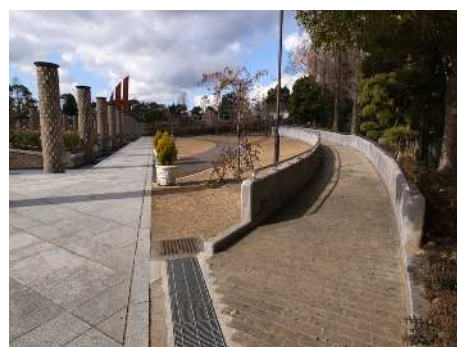
回遊式の公園にスロープを設けています。
