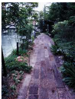
枕木を緑の中の遊歩道に採用しています。
