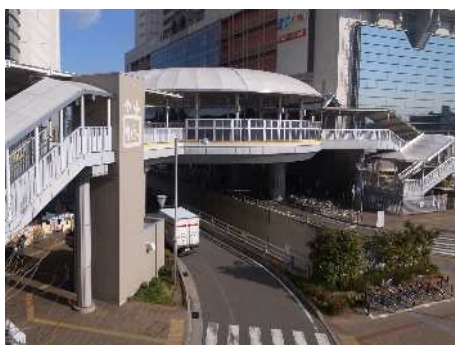
駅から続くデッキに歩行者用のエレベーターを設置しています。
