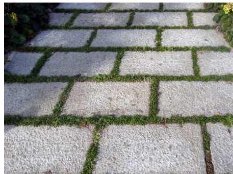
石材の目地の部分を緑化したしっとりとした質感の舗装です。
