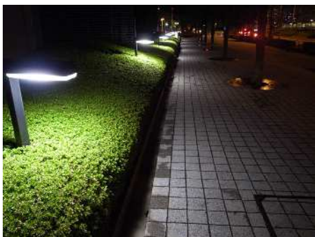
下向きの庭園灯で歩道を照らしつつ必要以上に光が広がらないようにしています。
