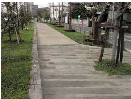
リサイクル資材である材木や間伐材を柵や舗装、縁石などに活かしています。 (戸田市)
