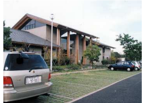
施設の前面に配置された駐車場を緑化して施設デザインをひきたてています。
