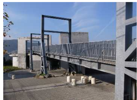
公園内の歩道橋をシンボリックなデザインとしています。
