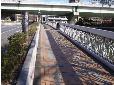
照明と高欄に同じパターンのデザインを採用しています。
