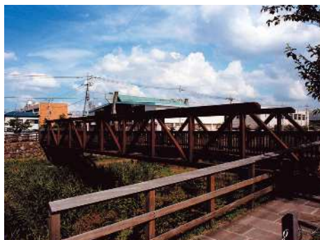
多自然型工法による河川改修に合わせ、木橋（人道橋）としています。（戸田市）
