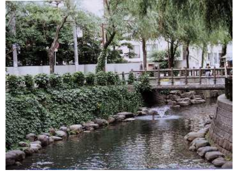
自然石とツタで護岸を修景しています。
