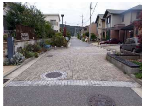
クランクと舗装の工夫によって車の速度低減を図っています。
