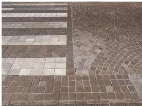
石材のサイズやパターンを工夫した風格のある舗装です。
