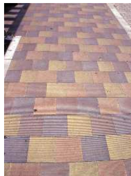
細かい溝を設けることにより滑りにくさに配慮しています。
