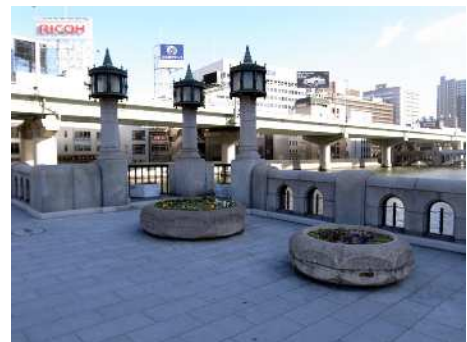
橋詰めにテラス状の空間を整備して水辺を眺められるようにしています。
