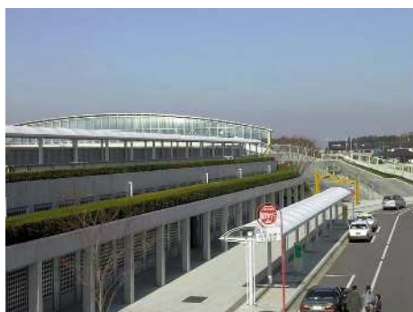
駅舎と一体的なデザインとし、屋上を緑化した駐輪場。
