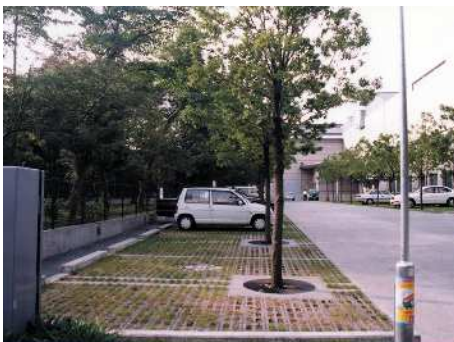
目立たない緑化ブロックによって駐車場区画を緑化しています。
