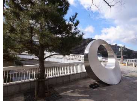
橋詰にパブリックアート作品を設置しています。
