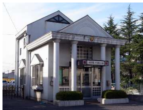
勾配屋根と伝統的なデザインモチーフにより象徴性を高めています。(戸田市)
