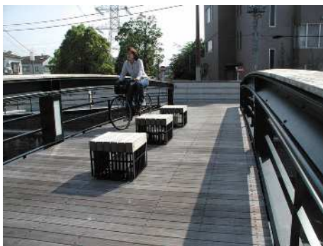
管路橋の上を歩行者や自転車が通れるようにしています。
