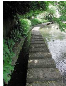
多孔質ブロックを用いて水質浄化を図っています。
