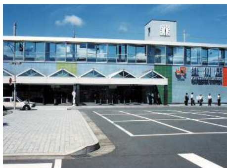
高架駅の壁面の工夫により健康的で明るい地域イメージを表現しています。
