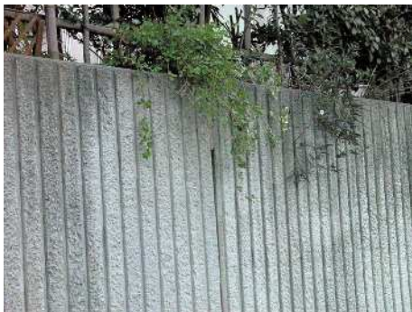
擁壁の仕上げを工夫し、表情を創り出しています。
