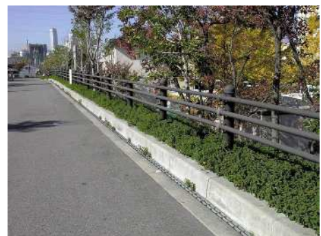
暗色系のガードパイプが緑になじんでいます。
