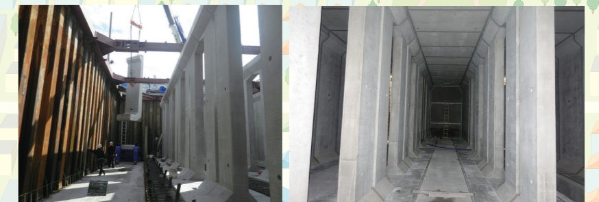
(工事中の状況)
