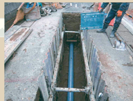
(工事中の状況)
