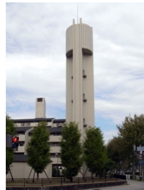
事例74 給水塔を建物と調和したデザイン・色彩としている。
