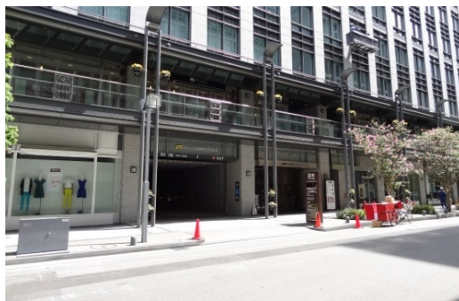
事例7 主要道路に面していない場所に駐車場出入口を設けるなどして、まち並みの連続性に配慮している。
