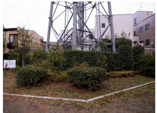
事例71 公園敷地内の送電鉄塔の足元に植栽を配置している。
