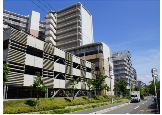
事例45 立体駐車場を、外観意匠や色彩等を工夫し建物と総合的にデザインしている。
