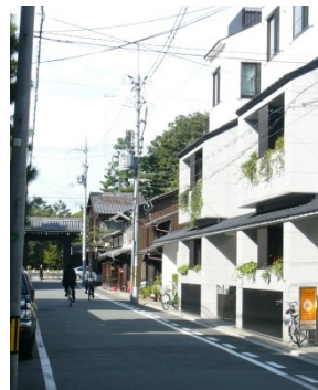
事例38 戸建て住宅の近くに立地する場合は、建物高さや屋根形状を工夫して圧迫感を与えないように努めている。
