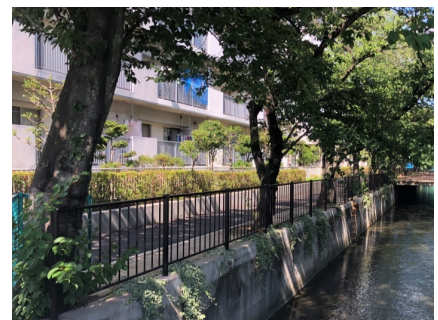
敷地の河川側に緑を配置している
