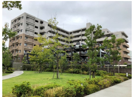
事例 57 壁面後退部分を駐車場として利用する場合は、緑化修景を施す。
