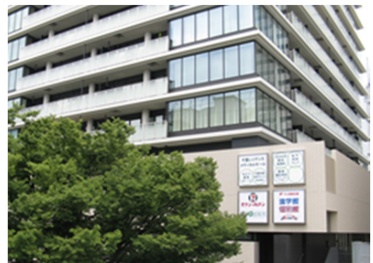
事例43 広告・看板類は極力数や大きさを抑え、すっきりと見せるよう努めている。
