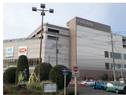
戸田駅前の商業施設の、すっきりとした印象の外壁
