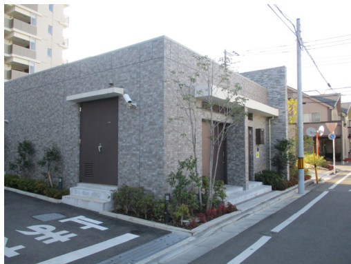
事例40 ゴミ置き場を、建物と一体的な上屋を設ける、緑でカバーする等の修景をしている。
