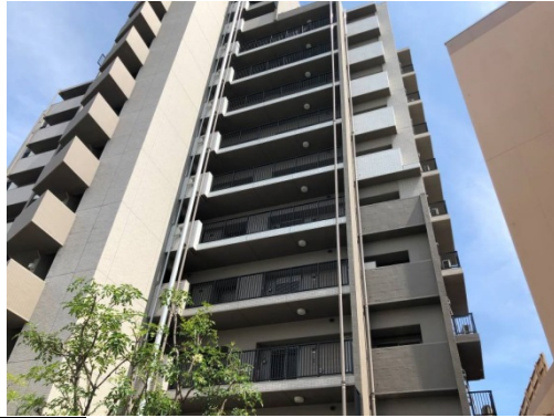
事例44 設備類を、壁面と同系色の塗装を施している。
