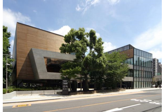
事例60 既存の樹木は保全し、外構デザインの一部としていかしている。
