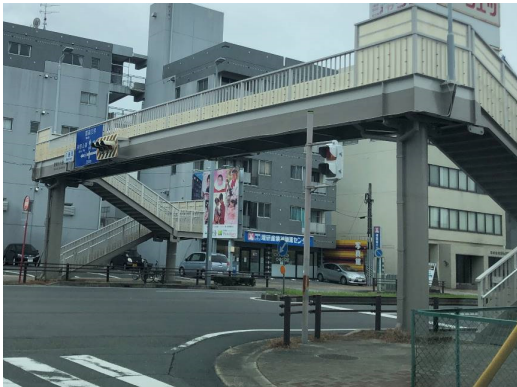
事例 79 歩道橋の桁を、同系統の色で上下に塗り分けることにより、スケール感を軽減している。
