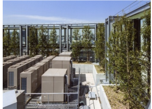
事例36 塔屋や屋上設備などは、ルーバーで覆う、壁面を立ち上げる等の修景をしている。
