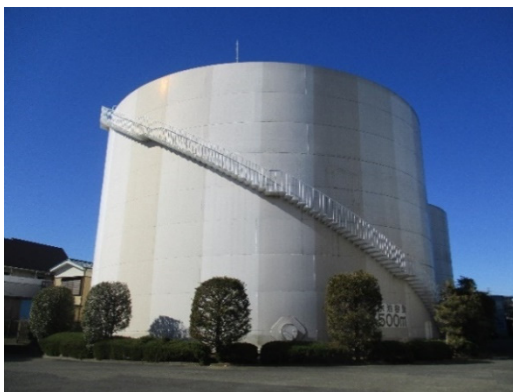
事例75 色彩を塗り分けることにより圧迫感を軽減したタンク
