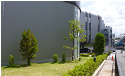
事例14 大規模な壁面は、雁行させたり色彩に変化をつけるなど、単調な連続を避けている。
