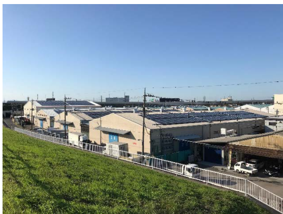
堤防上から望む倉庫群
