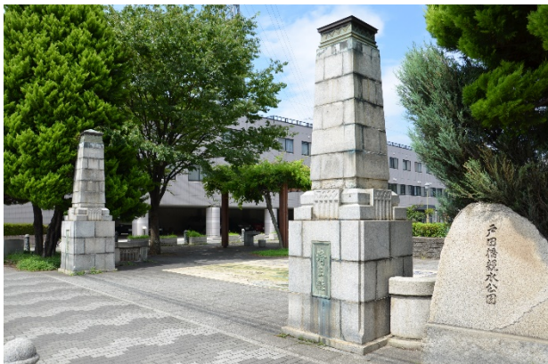
3代目戸田橋の親柱 (戸田橋親水公園)
