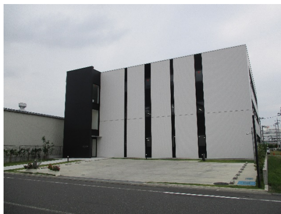
壁面を分節化するとともに、通りに開放感をもたらしている配置の工場
