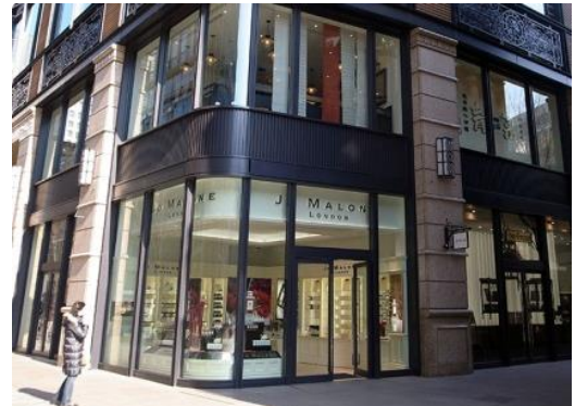
事例 26 店舗の構造体や開口部をアクセントとなるよう色彩に配慮し、にぎわいを演出している。
