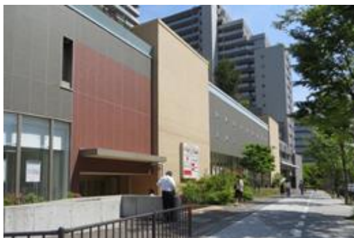
事例16 壁面に複数の色彩や素材を使用している。
