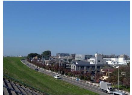
荒川沿いの道路から見た、まとまりのある建物のシルエット
