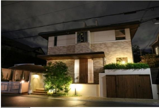
事例 64 玄関周りや敷地外周部に照明を配置し、やすらぎのある夜間景観の演出に努めている。
