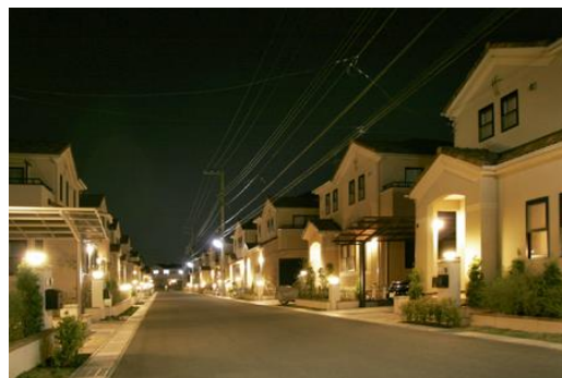
事例63 色温度の低い光源を用いている。
