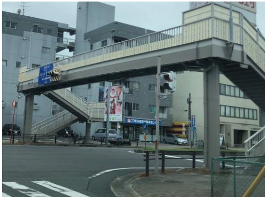
事例79 歩道橋の桁を、同系統の色で上下に塗り分けることにより、スケール感を軽減している。
