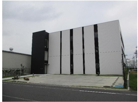
壁面を分節化するとともに、通りに開放感をもたらしている配置の工場
