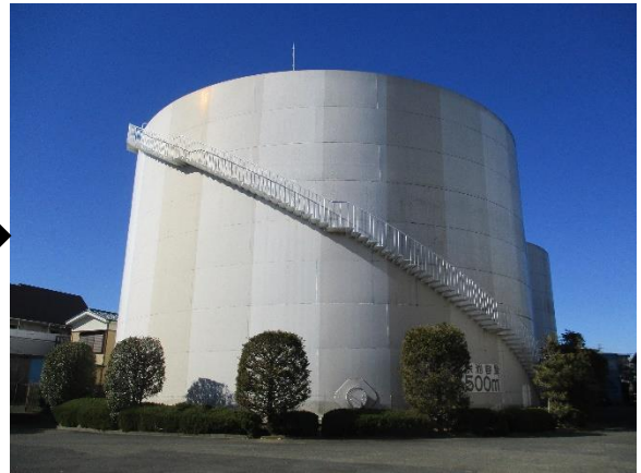
周辺の住宅地と調和するよう 塗り替えが行われた西部浄水場の配水タンク
