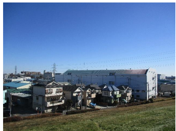
様々な規模と用途の建物が混在するまち並み
