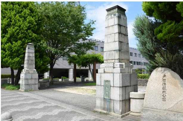
3代目戸田橋の親柱 (戸田橋親水公園)
