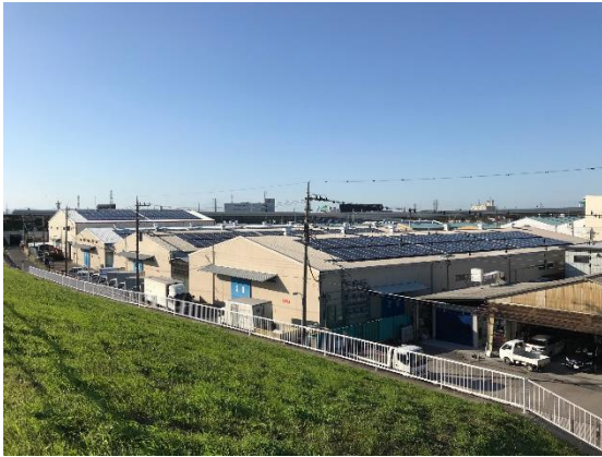
堤防上から望む倉庫群
