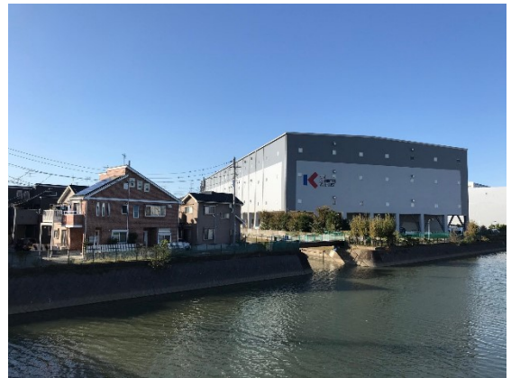
隣接する住宅と倉庫
