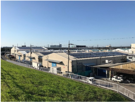
堤防上から望む倉庫群
