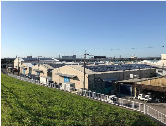
堤防上から望む倉庫群
