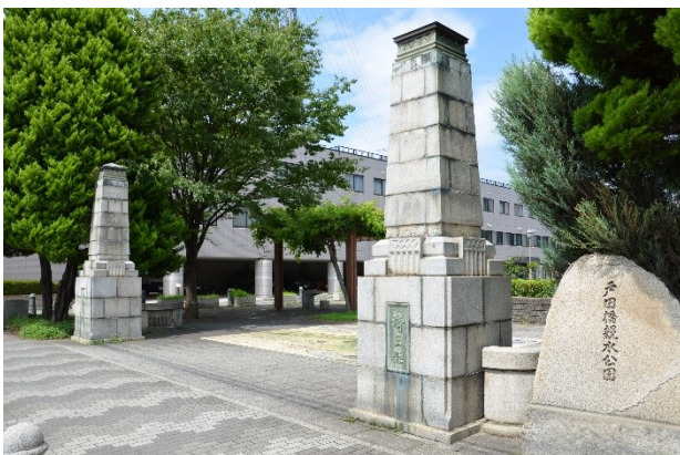
3代目戸田橋の親柱 (戸田橋親水公園)
