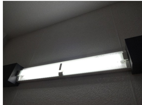
場所：2階から屋上への階段
