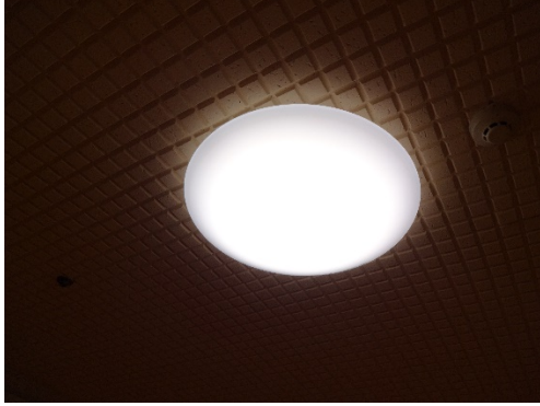
場所：1階 事務所出入口
