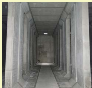
完成した調整池内部
