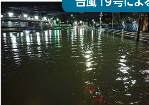
戸田公園駅バスロータリー付近
