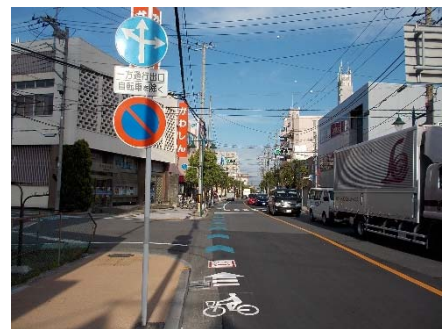
整備済みの自転車通行空間
