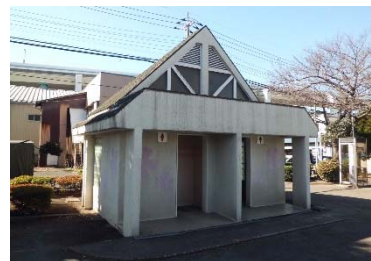
砂場公園便所改修
