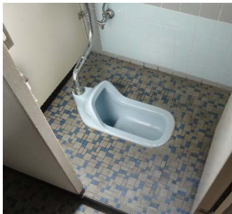
【改修前】共用トイレ
