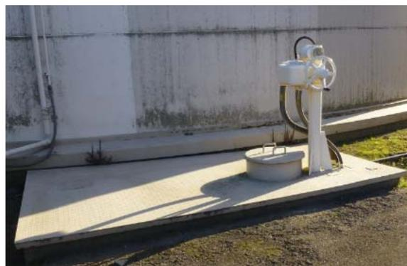
写真:西部浄水場緊急遮断弁 (昭和 48 年設置)
