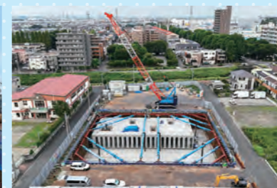
工場で作られた部材を120トンクレーンで吊り込みました
