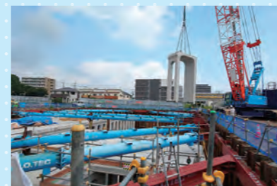
工場で作られた部材を120トンクレーンで吊り込みました
