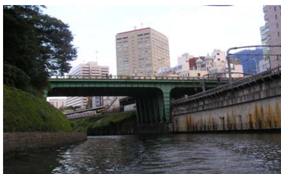
神田川から見る聖橋
