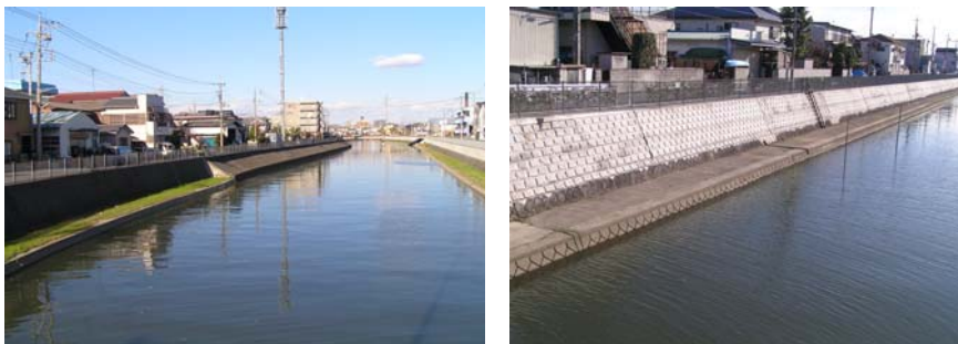
《戸田市側護岸整備》
