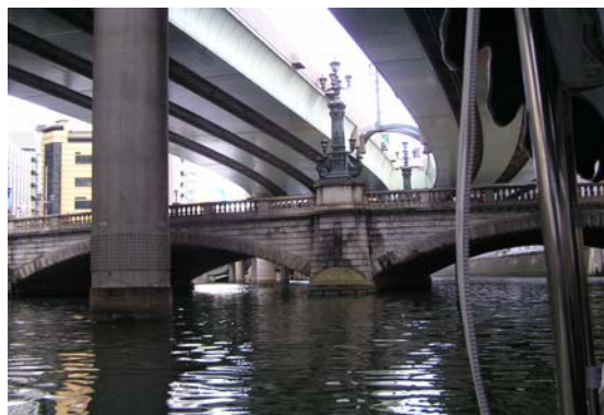
日本橋川から見る日本橋
