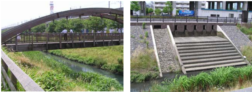
《さいたま市側護岸整備》
