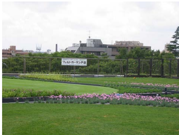
写真 1-3 屋上緑化「フェルトガーデン戸田」
