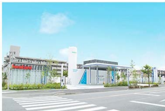
「イワタニ水素ステーション埼玉戸田（新曽 2323）」 出典：一般社団法人次世代自動車振興センターホームページ
